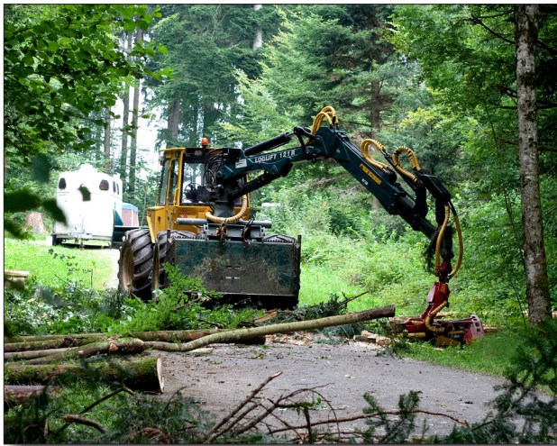
Petit chantier forestier
